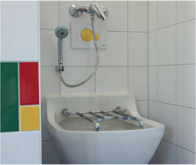
Kindergarten Clementinenhaus in Crossen (Thüringen) Mit dem Vorwandelement für wandhängende Fäkalablassbecken „Bernina“ wird die Arbeit beim Ausleeren und Nachreinigen der Töpfchen erheblich erleichtert.
